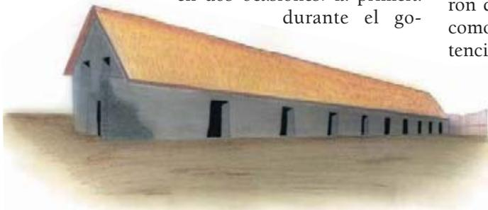
*La kallanka incaica, llamada galpón por los españoles. Este espacio de planta rectangular tenía pilares de madera que sostenían el techo de dos aguas. Ilustración que reconstruye la kallanka norte de Huánuco Pampa, tomada de Gasparini y Margolies 1977.*
